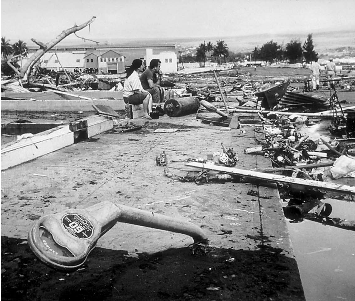
Fotografía de la izquierda: Consecuencias del tsunami chileno de 1960 en Hilo, Hawai, donde el tsunami causó 61 muertes.
